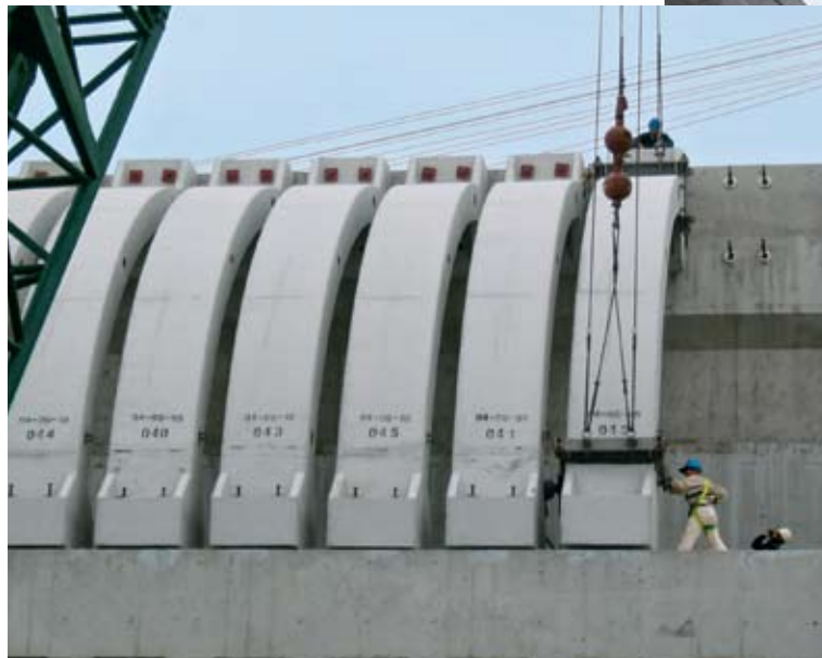
Wellenbrecher aus Fertigteilen, Jeju Hafenausbau, Süd-Korea
