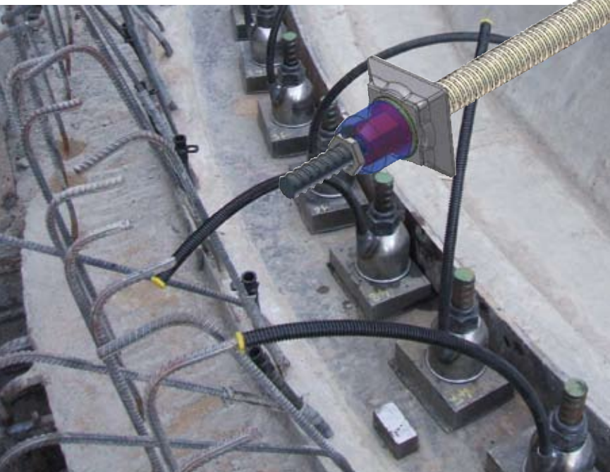
Stabspannglieder mit Verbund, mit QR-Platten bzw. quadratischen und rechteckigen Vollplatten-Verankerungen
